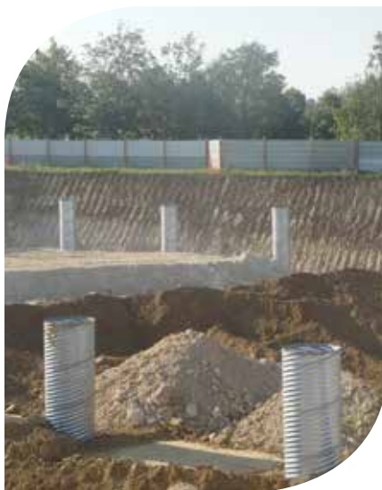
Schacht met flenskoppeling
