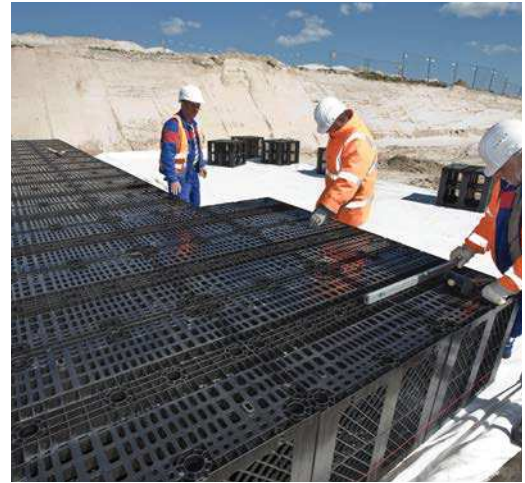
Installing the RAUSIKKO Boxes
