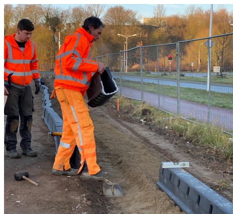
Handmatig plaatsen van bandafwatering
