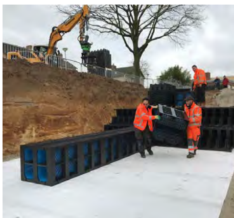
Eenvoudige en snelle plaatsing
