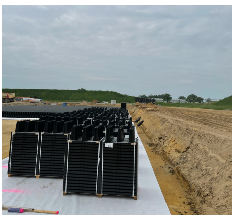
Eenvoudige en snelle plaatsing
